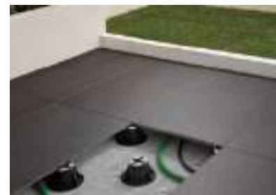
5. POSA SOPRAELEVATA LAYING AS RAISED PAVING Trockene Verlegung auf Stützen / Pose surélevée
