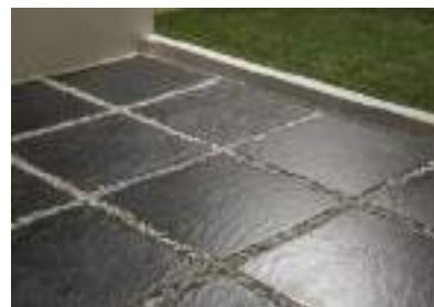
2. POSA SU GHIAIA LAYING ON GRAVEL Trockene Verlegung auf Kies / Pose sur gravier
